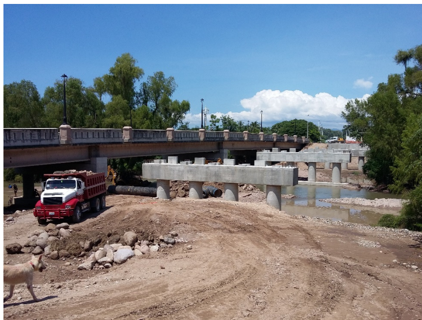
Imagen 28: Proceso de obra de puente vehicular. Fuente: Propia.
