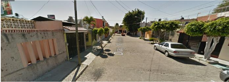
Figura 3. Casas habitación alrededor de Akrobic gym
