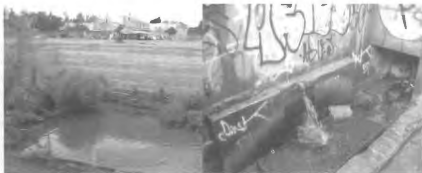
Figura 1. Manantial Colomitos afectado por la construcción a un costado.
