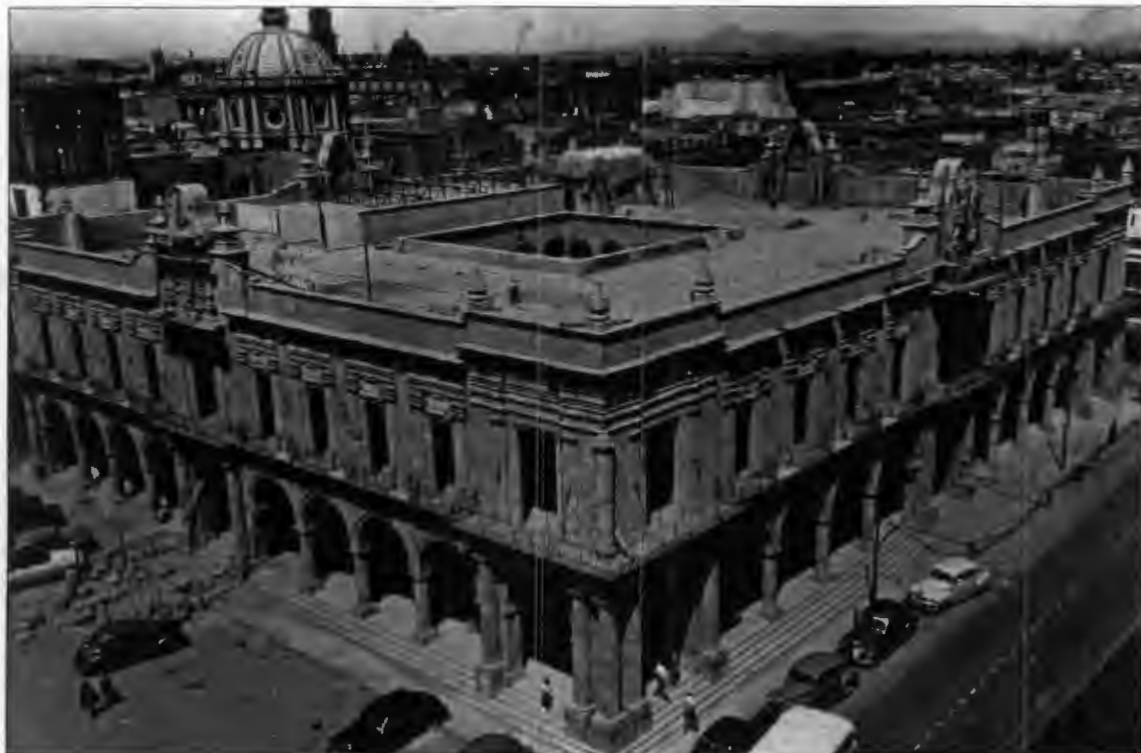
FIGURA 56. La construcción del Palacio Municipal casi terminada.
