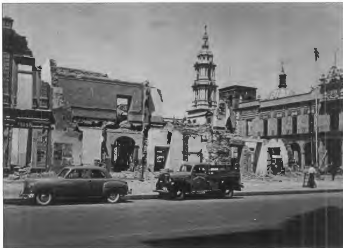
FIGURA 42. Demolición de las fincas que se encontraban frente a la Catedral.
