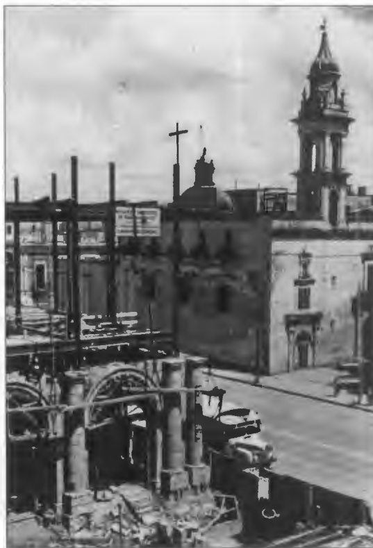
FIGURA 12. El santuario de la Soledad y el nuevo Palacio Municipal en construcción.
