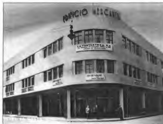
FIGURA 19. Edificio que se construyó en lo que fueron las Casas Consistoriales-Ayuntamiento de Guadalajara.
