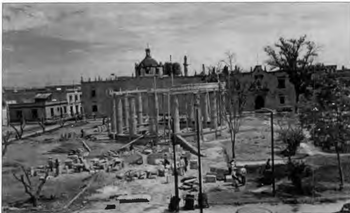
FIGURA 52. Construcción de la Rotonda de los Jaliscienses Ilustres en el predio que ocupó el Jardín de La Soledad, 1952.
