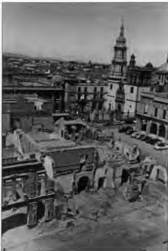
FIGURA 43. Demolición de las fincas que se encontraban frente a la Catedral, 1952.
