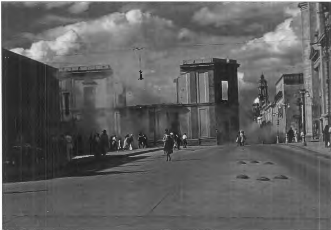
FIGURA 25. Demolición del antiguo Palacio del Municipal.
