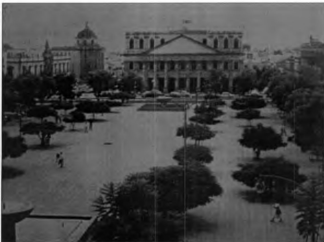
FIGURA 68. La Plaza de la Liberación recién terminada su construcción.
