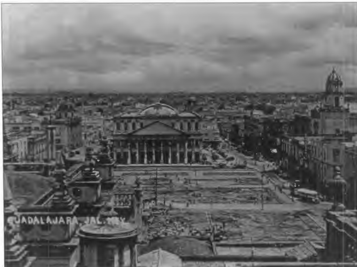
FIGURA 67. Inicio de la construcción de la Plaza de la Liberación.
