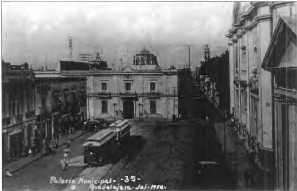
FIGURA 30. Vista del antiguo Palacio Municipal.
