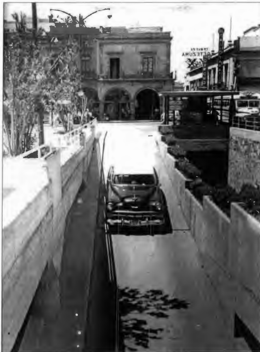
FIGURA 50. Rampa de ingreso al estacionamiento subterráneo de la Plaza de los Laureles, hoy Plaza Guadalajara.
