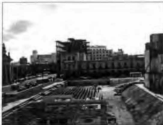
FIGURA 44. Construcción del estacionamiento subterráneo de la Plaza de los Laureles, hoy Plaza Guadalajara, 1952.
