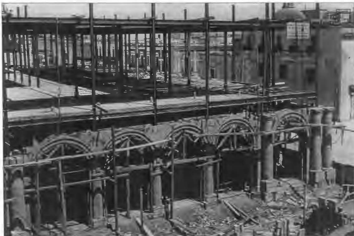
FIGURA 55. Construcción en proceso del Palacio Municipal.
