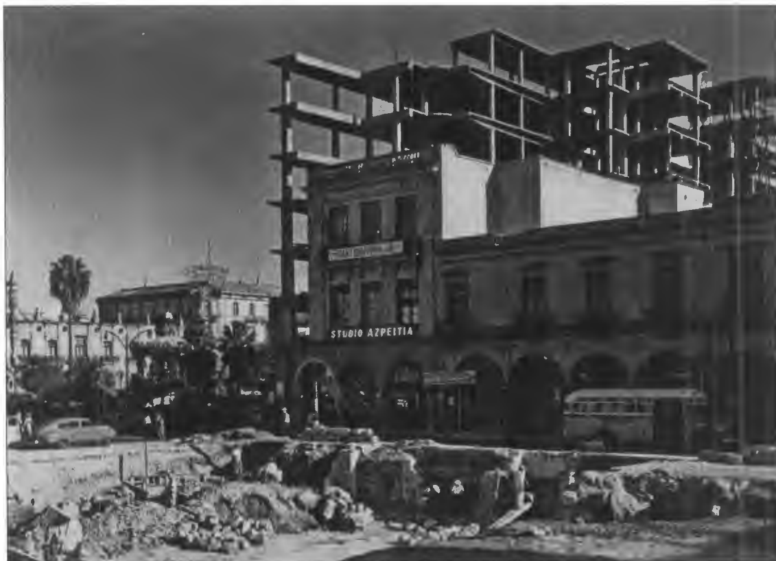
FIGURA 40. Destrucción de la manzana frente a la Catedral, en lo que hoy es la Plaza Guadalajara, antes la Plaza de los Laureles.
