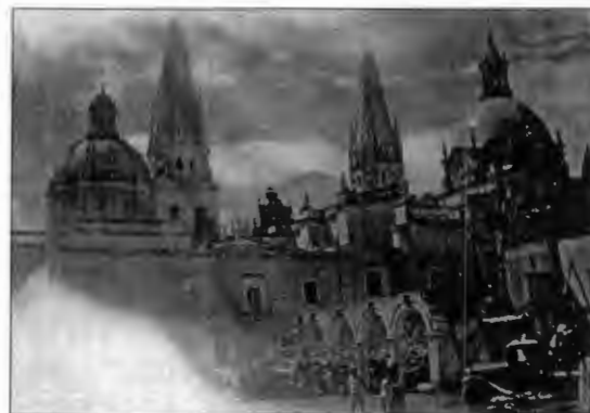
FIGURA 18. Vista de la demolición, donde se observa la arquería del patio central, 1923.
