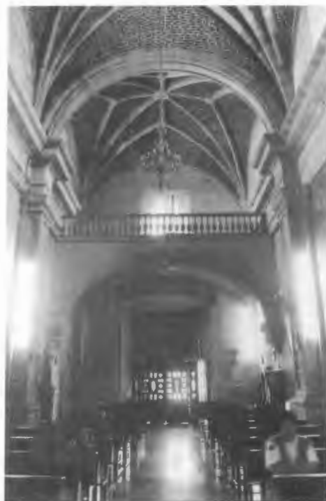
Vista desde el interior al ingreso principal del templo de Capuchinas.
